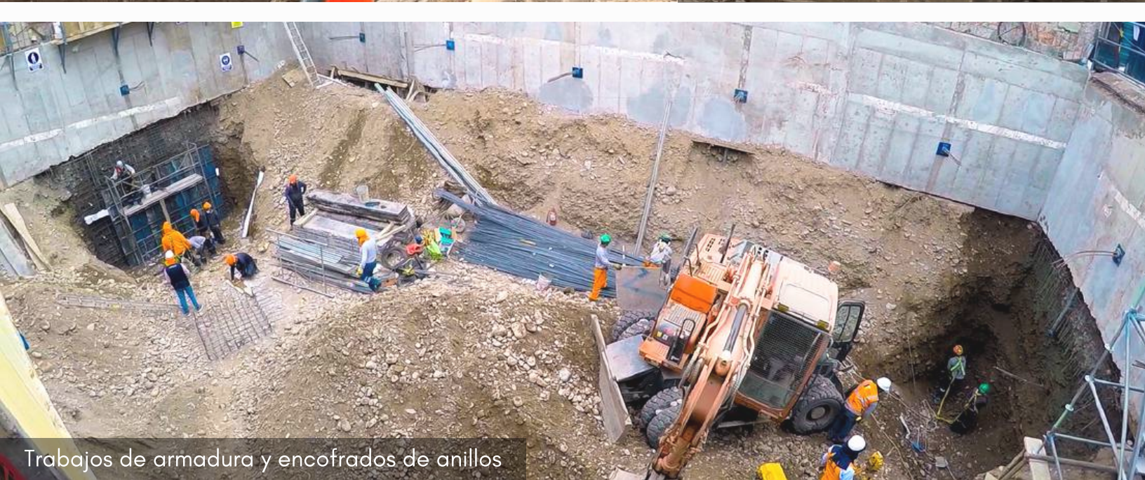
Trabajos de excavación masiva
