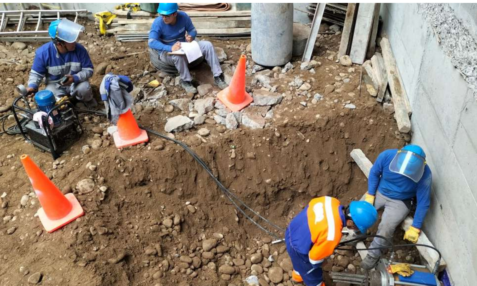
Tensado de anclajes
