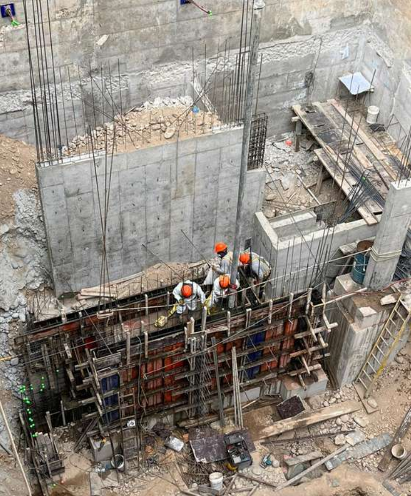
Encofrado de placas
