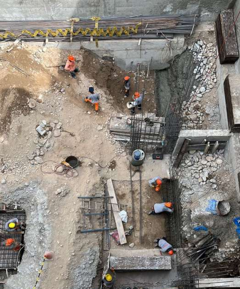
Colocación de acero
