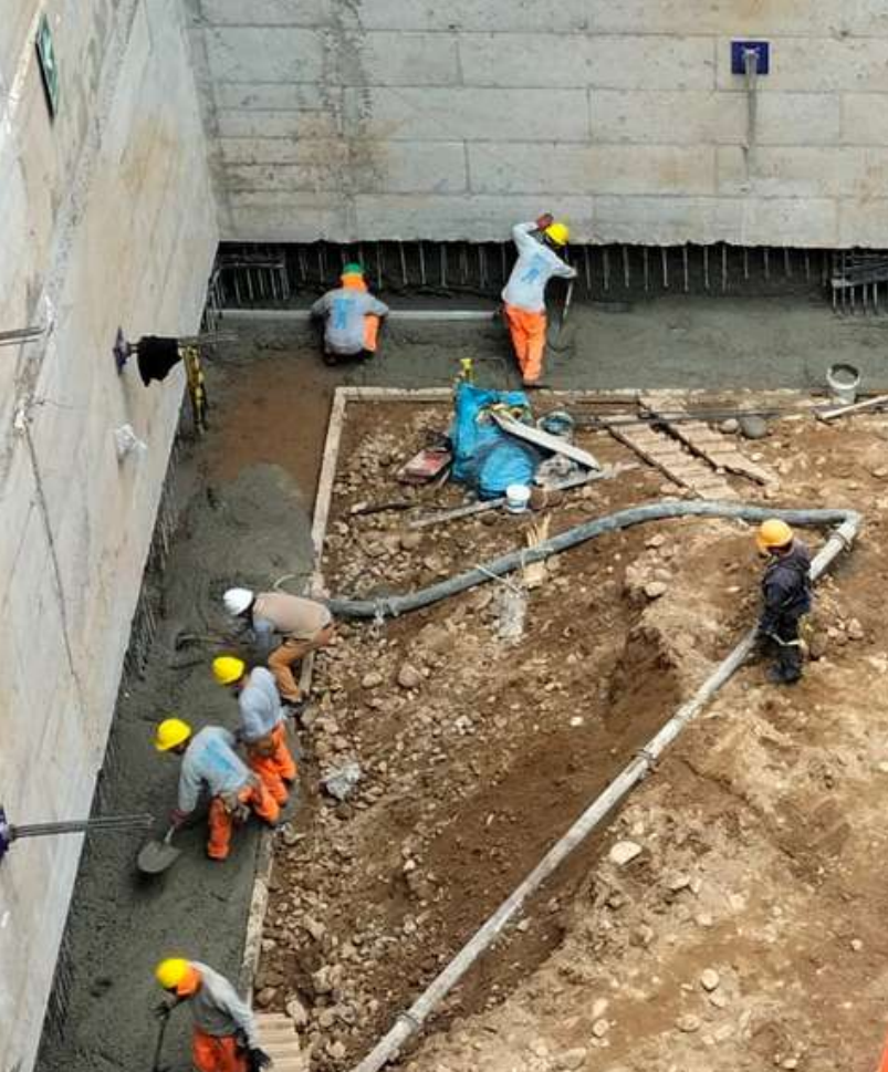
Vaciado de solado de zapatas
