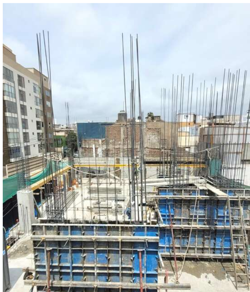
Encofrado de placas
