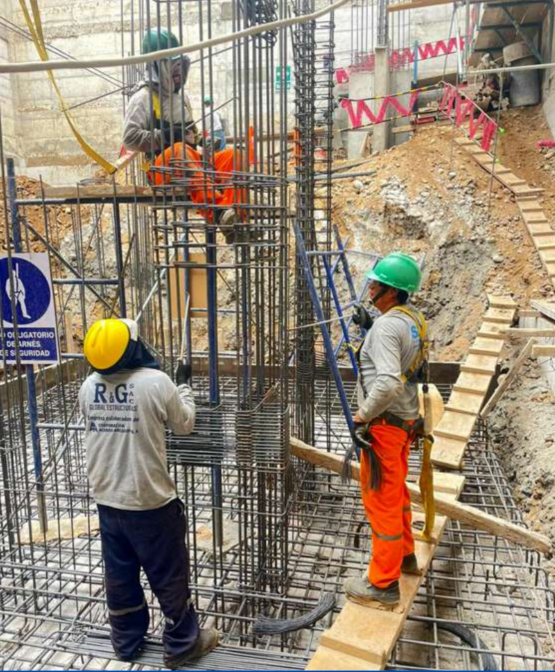
Avance de placa del ascensor
