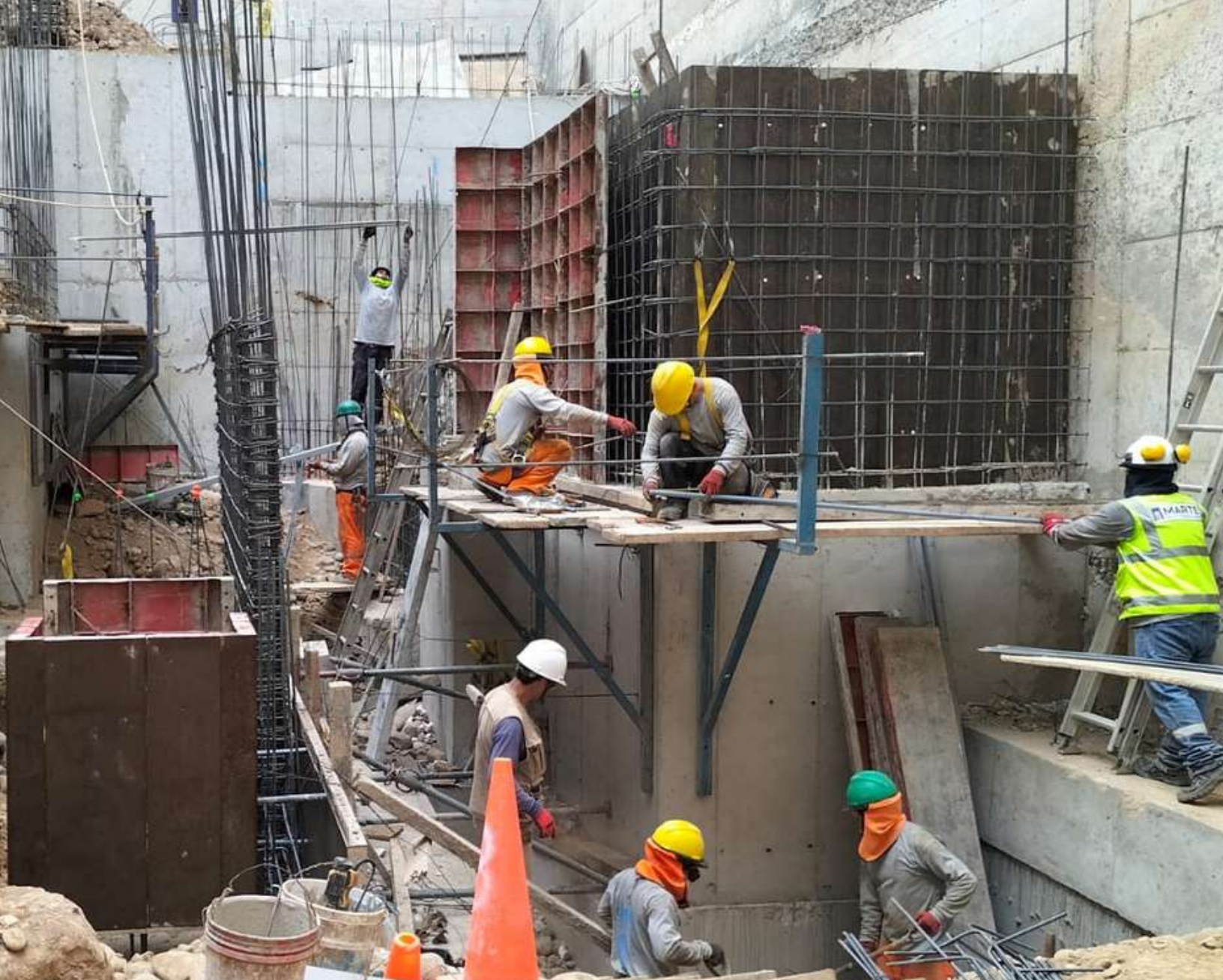
Encofrado de muros a doble altura (encimado) en sótanos
