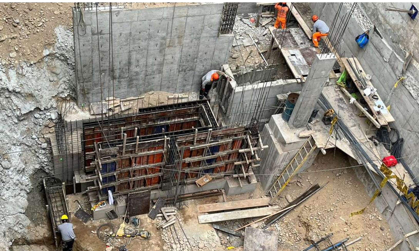
Encofrado de placas y muros de cisterna
