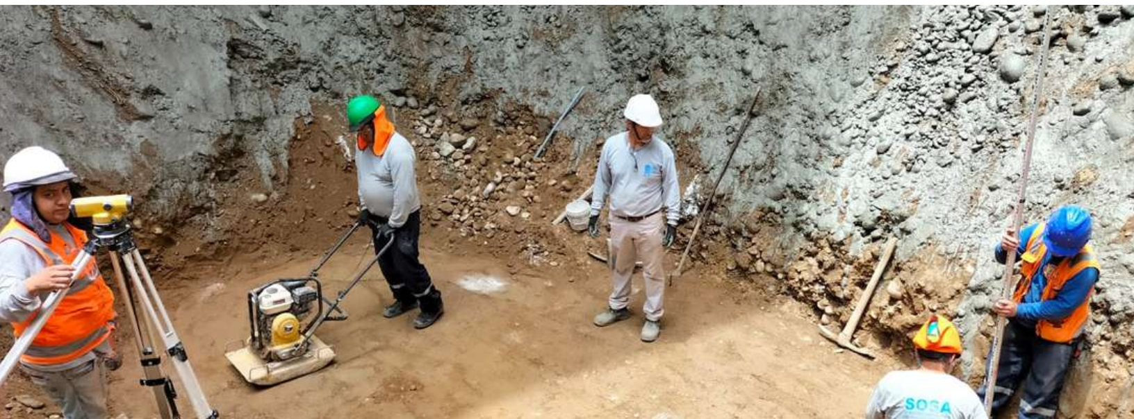
Nivelación topográfica y compactación de base para solado
