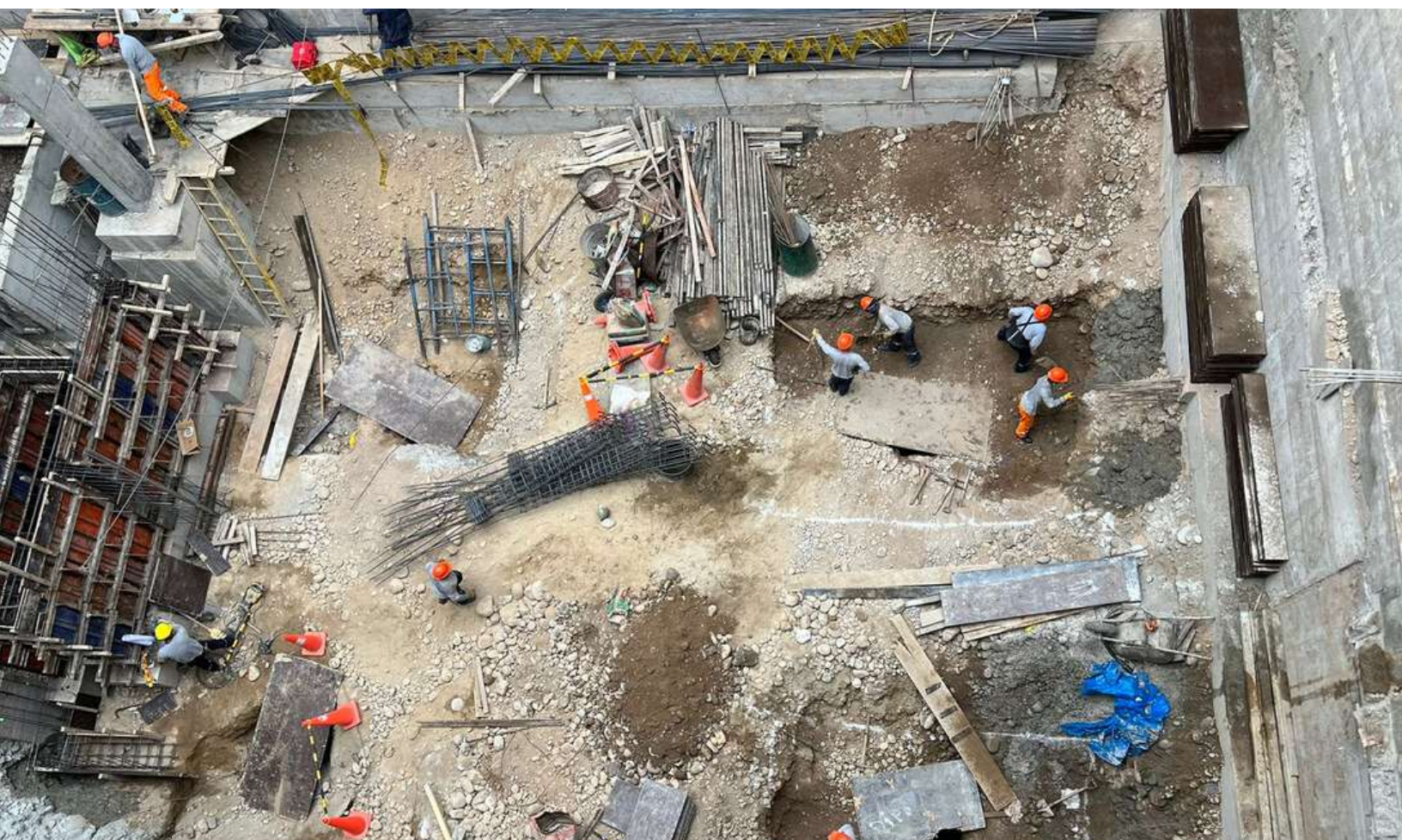
Excavación y perfilado manual de cimentaciones
