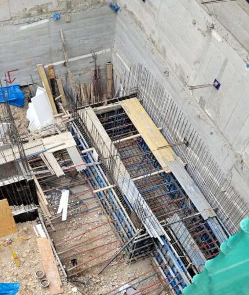
Encofrado de cisterna de consumo doméstico
